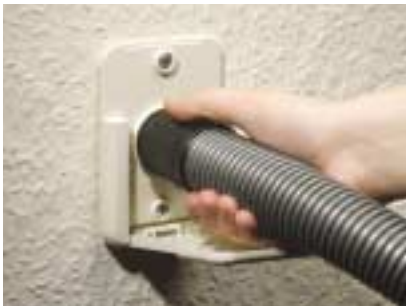
Εικ. 1-2: Σύνδεση του εύκαμπτου σωλήνα απορρόφησης
