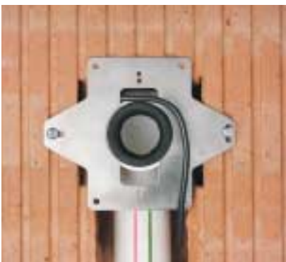
Εικ.5-35: Τοποθετημένο πλαίσιο συναρμολόγησης και καλώδιο ελέγχου
